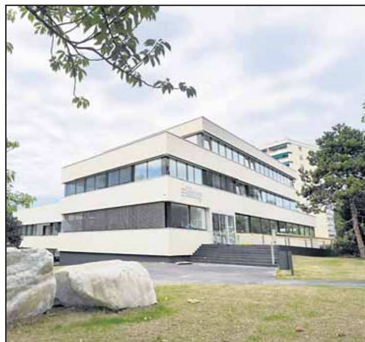
L'IDHEAP se dote d'un bâtiment pour accueillir quelque 600 étudiants et 80 collaborateurs. ARC
